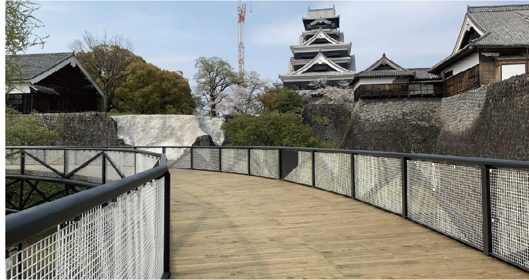
熊本市 熊本城特別見学通路 ボードウォーク：熊本県産松材
