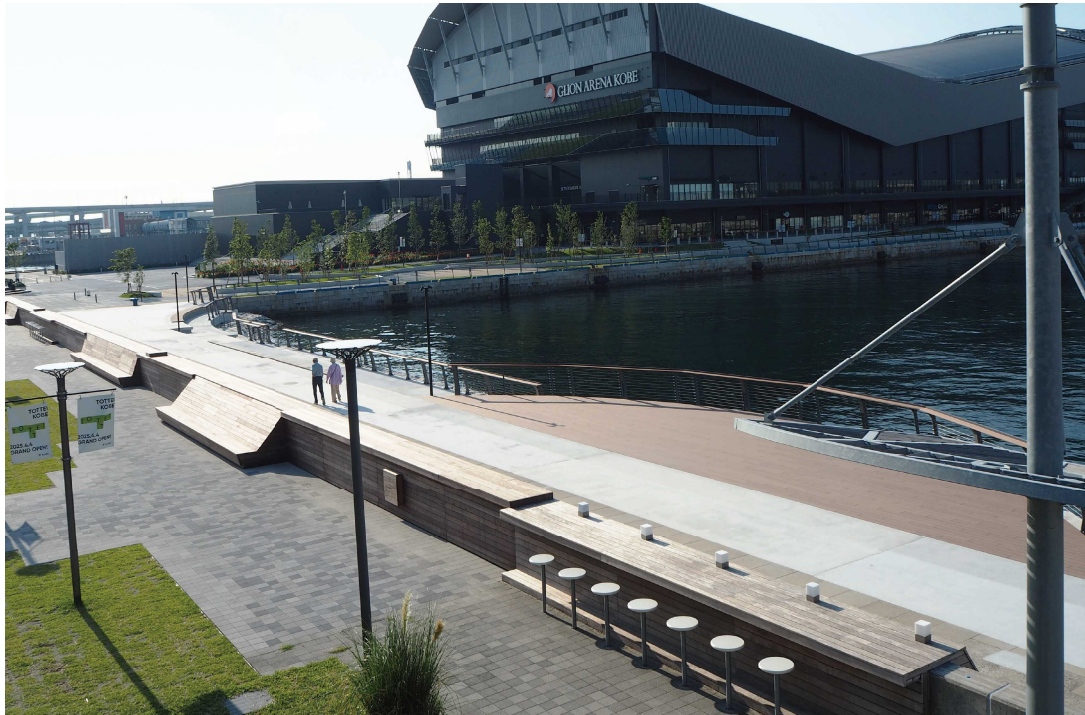
神戸市 新港2突堤部倉庫跡地暫定広場 デッキベンチ：イタウバ材
