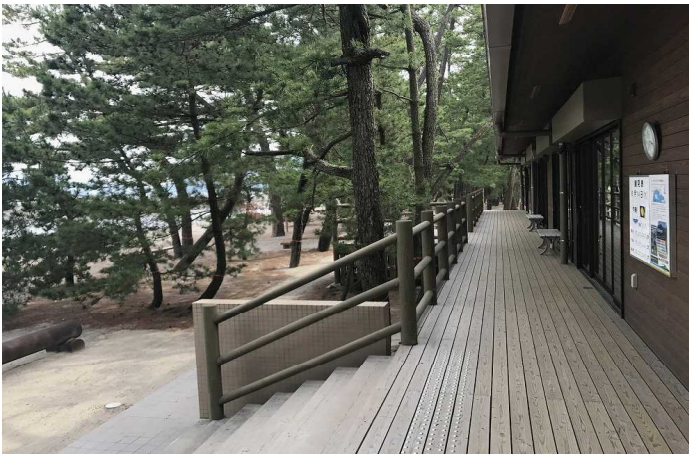
始良市 なぎさミュージアム デッキ：国産杉材
