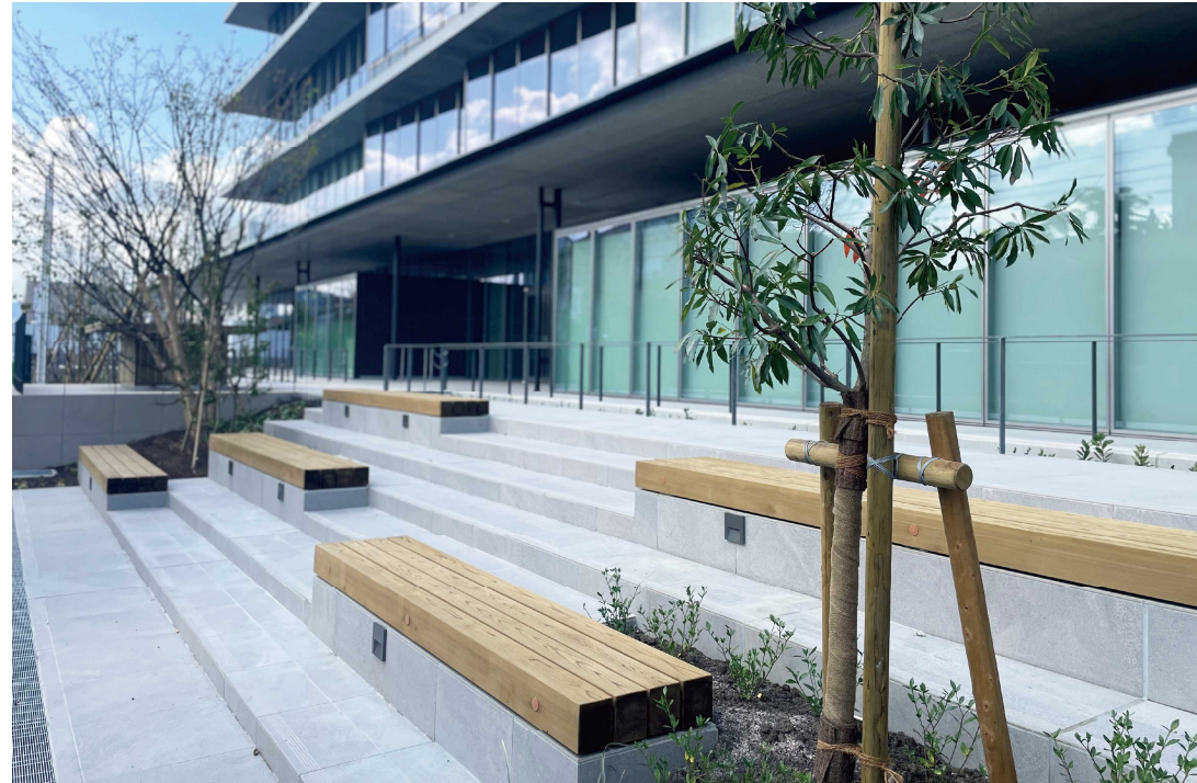
静岡県 島田市役所 ベンチ：島田市産杉材
