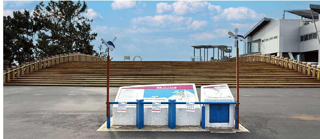
泉佐野市 りんくう公園太鼓橋改修 木製デッキ：国産杉材
